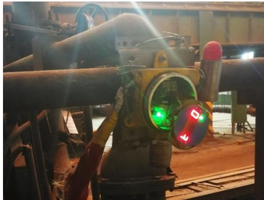
图 2-2 固定式一氧化碳监测报警装置损坏
