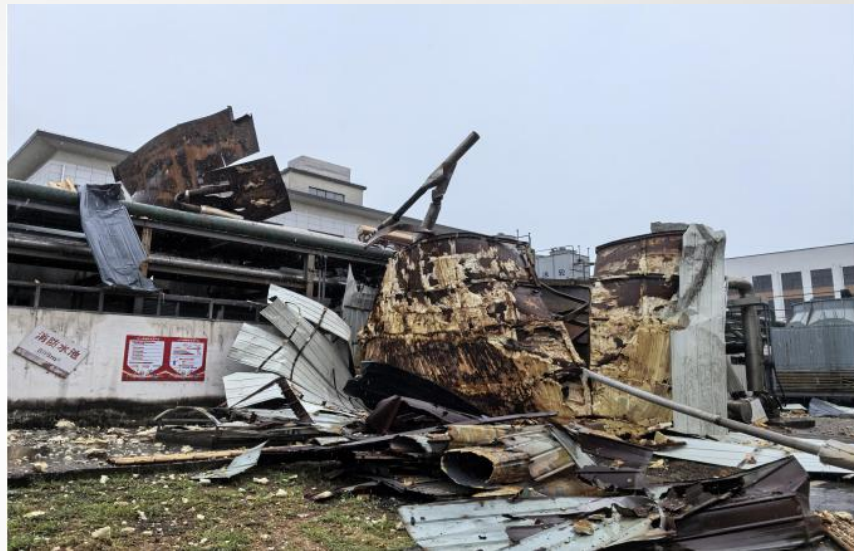
2024.7.12国内某企业盐水箱打磨发生闪爆事故
